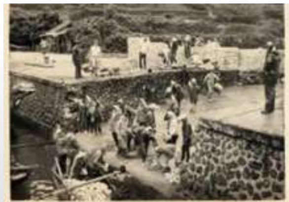
臺灣運送過來之建監材料（紅磚），於綠島南寮漁港搬運情形。
