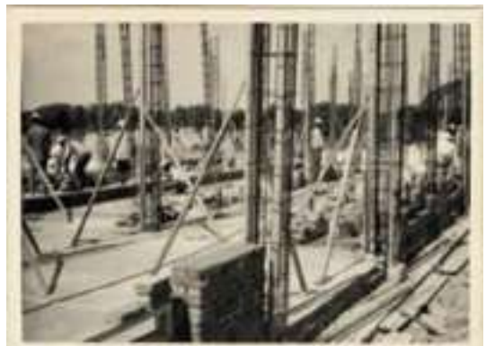
舍房工地配管情形
