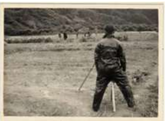
建監用地為較平斜之山坡地，地勢呈前低後高，且為砂質土壤，雇用之伍作業導師必須測量以便整地。
