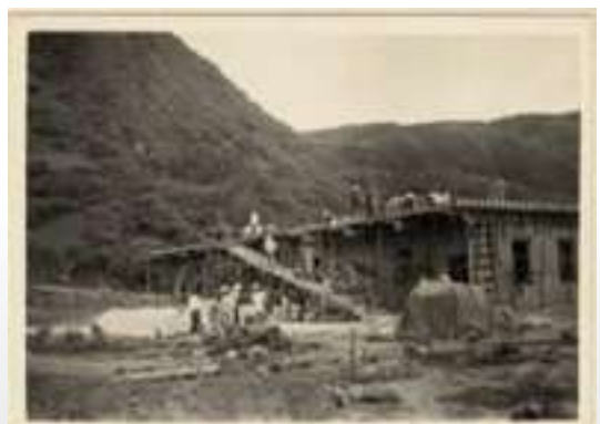
舍房工地水泥灌漿情形
