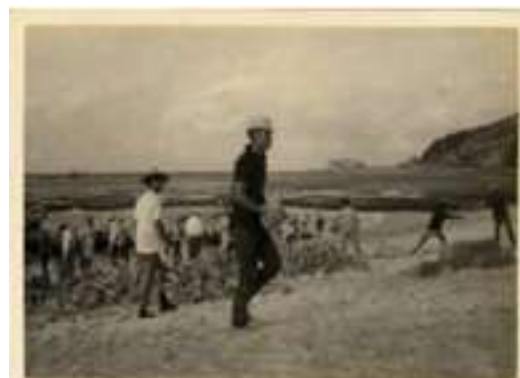
臺灣運送過來之建監材料（紅磚），於綠島中寮漁港人龍傳送情形。
