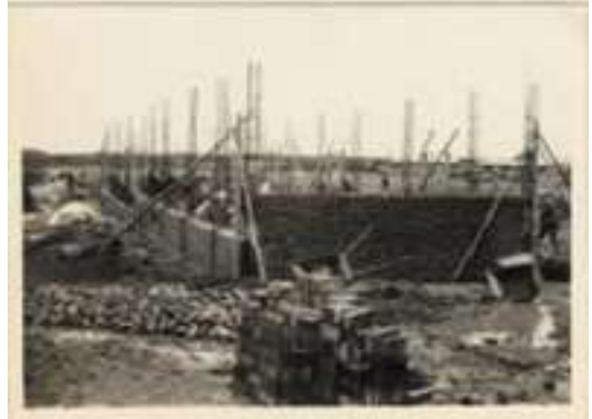
舍房工地砌磚情形
