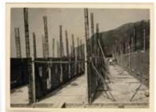
舍房工地砌磚、立柱、配管情形
