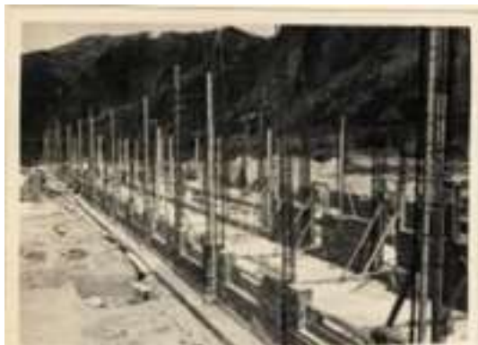
舍房工地立柱情形
